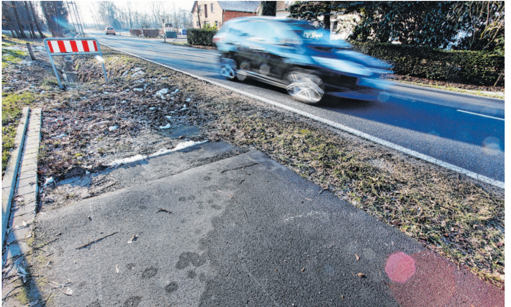
Noch endet er hier: Der Radweg an der Ostseite der Österwieher Straße ist wenige Meter hinter der Einmündung des Reckerdamm zu Ende. In diesem Jahr soll der 2,2 Kilometer lange Lückenschluss bis zur Neuenkirchener Straße gebaut werden. FOTO: ROLAND THÖRING
